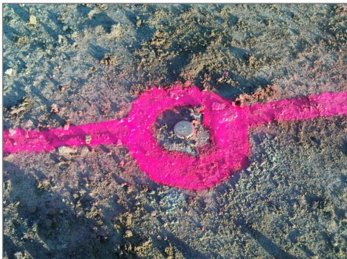
**Abbildung 5: Vermarkung einer Bauachse durch einen Bolzen mit Körnung**
