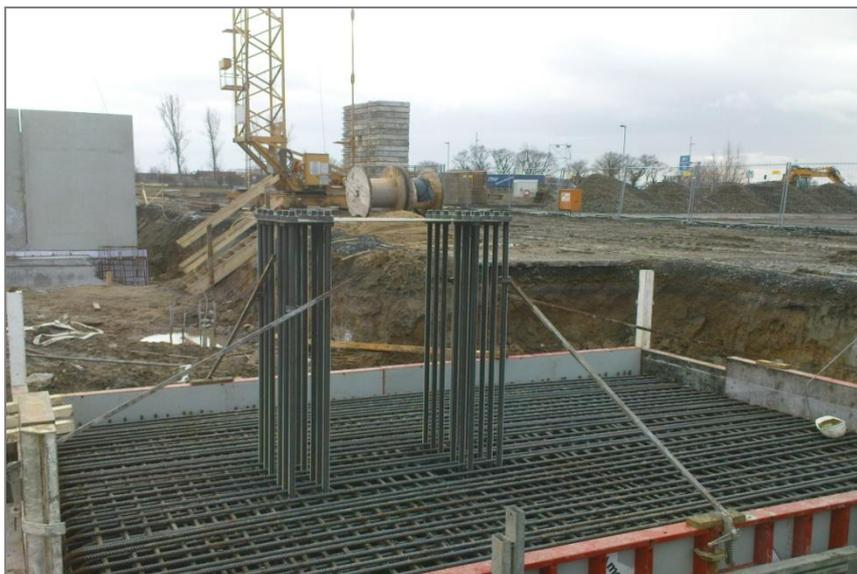
Abbildung 3: Eines der Einbauteile, bereit zum Guss des Fundamentes
